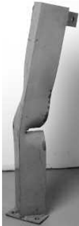
Figure 56. Protecteur de montant endommagé (Photo : Maurice Vézinnet)
