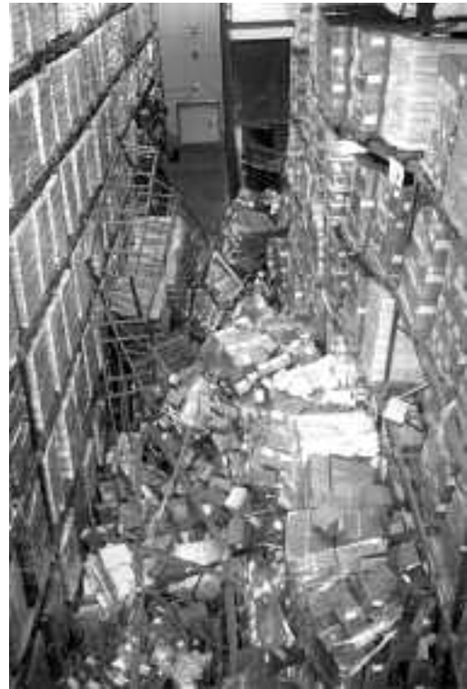
Figure 3. Effondrement d'un palettier
